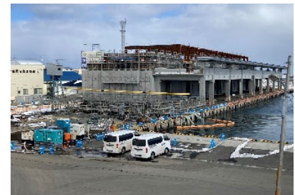
建設中の高度衛生管理型市場
