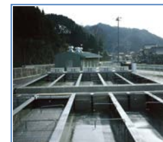
さけ・ます 種苗生産施設
