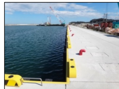
岸壁の耐震強化
