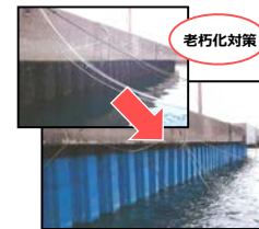
漁港施設の計画的な長寿命化対策
