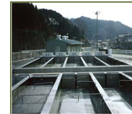
さけ・ます 種苗生産施設
