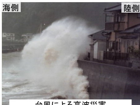
台風による高波災害 (平成16年 大分県臼杵漁港海岸)
