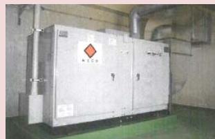
非常用電源の導入
