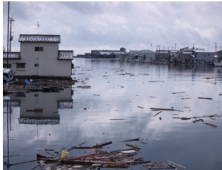
【東日本大震災被害状況】
