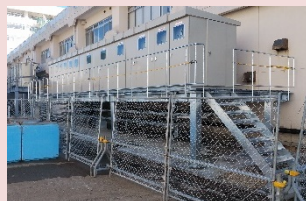
電源施設の高架化
