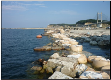
地震により岸壁が倒壊
