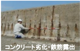
コンクリート劣化・鉄筋露出
