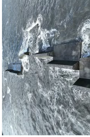
防波堤の倒壊 (令和6年2月の冬期風浪)
