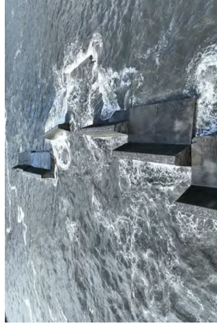
防波堤の倒壊 (令和6年2月の冬期風浪)
