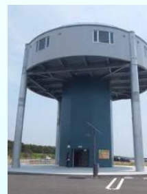
津波避難タワー
