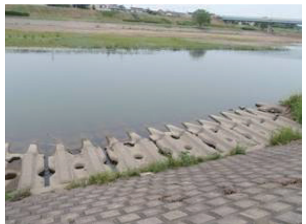
写真 3 入間川田島屋堰下流。手前が右岸側で、護岸ブロックが投入されている
