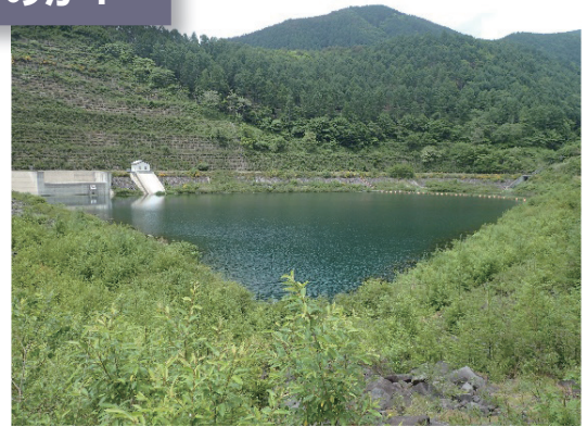
写真1. 金原ダム（長野県東御市）
