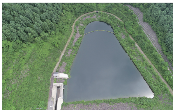
写真1. 金原ダム(長野県東御市)
