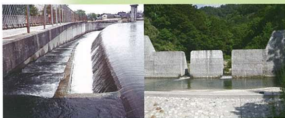
水の流れる魚道の設置や堰堤のスリット化
