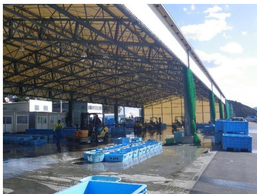
写真 テント式仮設荷さばき所 (志津川漁港)
