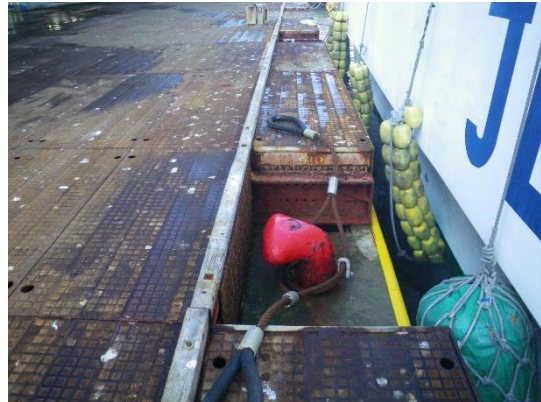
写真 鋼材を用いた応急嵩上げ（気仙沼漁港）
