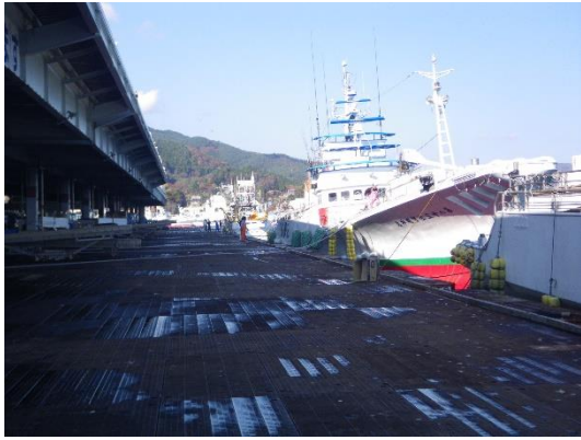
写真 鋼材を用いた応急嵩上げ（気仙沼漁港）
