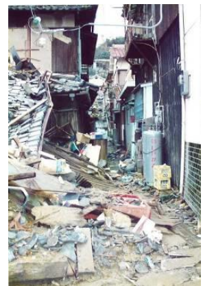
家屋の倒壊により塞がれた集落内の細路地 (阪神・淡路大震災：兵庫県旧北淡町)
