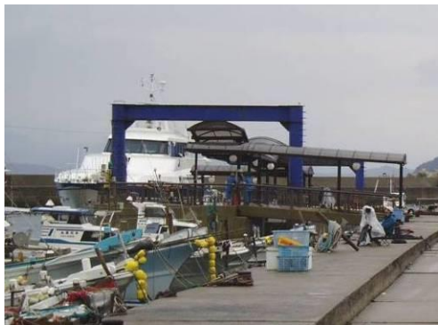
緊急時の海路として利用された浮体式係船岸
