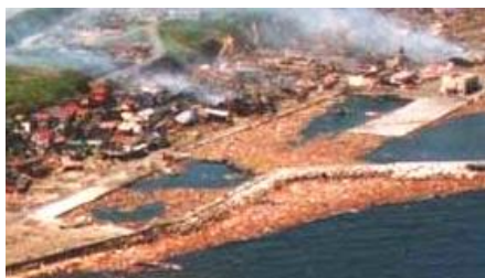
漂流物の港内滞留による海路遮断 （北海道南西沖地震津波による漂流物被害：北海道奥尻町青苗漁港）
