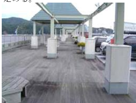
津波避難施設（宮城県気仙沼漁港）
