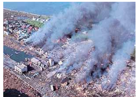
北海道南西沖地震による奥尻町青苗地区の火災 (北海道奥尻町)
