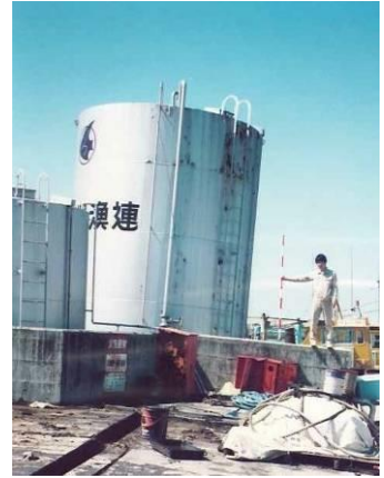
阪神・淡路大震災による給油タンクの被害 (兵庫県育波漁港)
