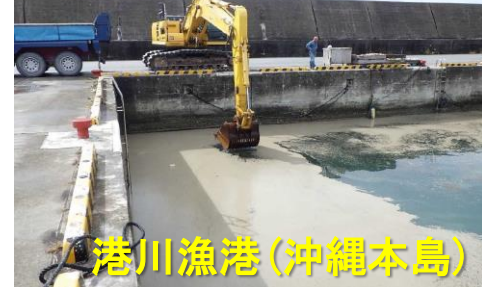
軽石除去作業 (港川漁港)
