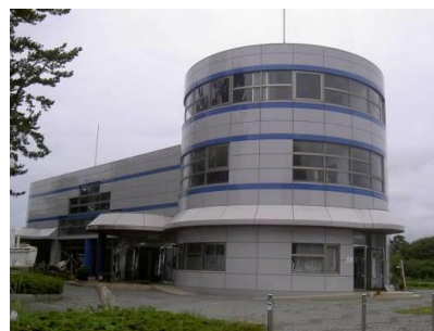
津波避難ビル (宮城県気仙沼市波路上地区の岩井崎プロムナードセンター)
