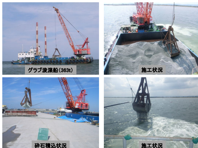
図10-1：グラブ船による施工
