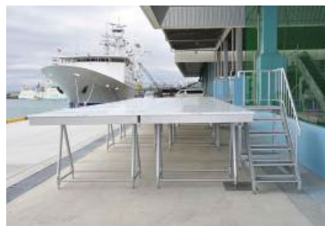
ステンレス製板台の設置
