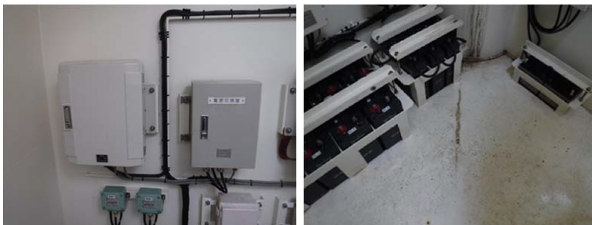
図- 3.12 室内機器の点検
