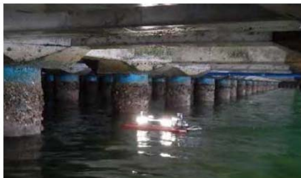
ROV による撮影状況
