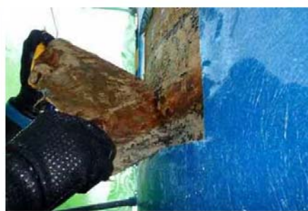
被覆工の除去
