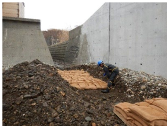
用水での施肥材設置状況
