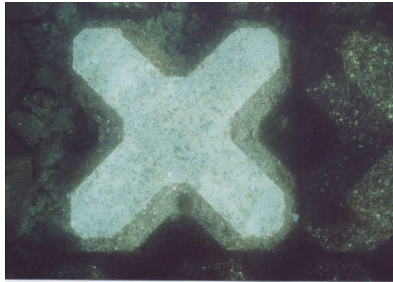
図1 コンクリートブロック表面に付着したカキ殻等を削り取った状態（3月）
