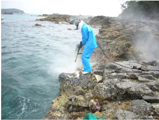
図 7-D5-5 高圧洗浄機による岩盤清掃
