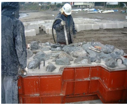
植石ブロックの製作状況
