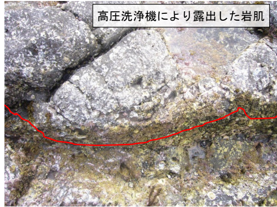
図 7-D5-5 高圧洗浄機による岩盤清掃
