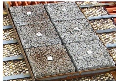
多孔質コンクリート版の設置状況
