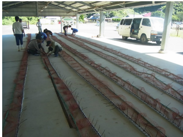
図8-1-1 ウニフェンスの製作
