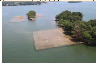
○松島湾名籠工区施工状況(完成)
