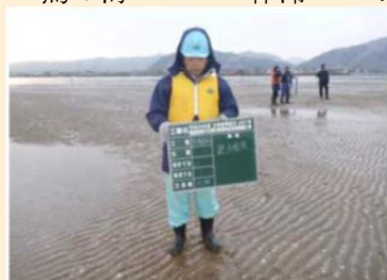
○万石浦干潟造成石巻湾工区施工状況 (平成25年度分完成)
