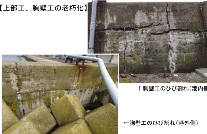
上部工のひび割れ、欠損
