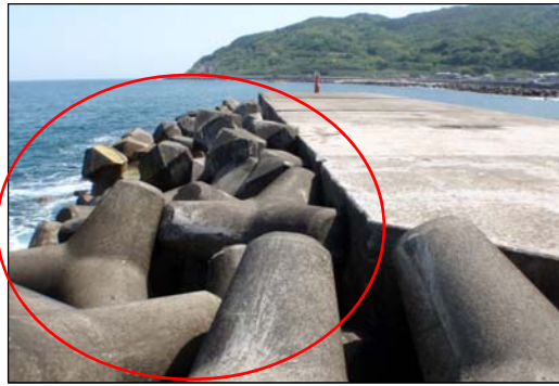
写真(補修前・補修後)
