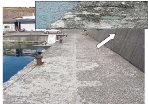
上部工のひび割れ、欠損
