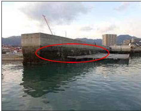
写真(補修前・補修後)
