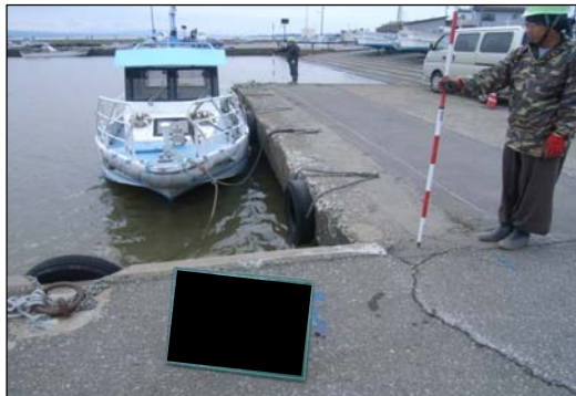
写真(補修前・補修後)
