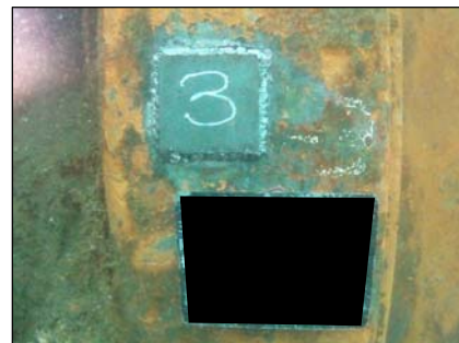
アルミニウム合金陽極設置
