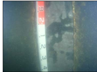
矢板の腐食、開孔
