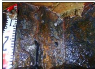
矢板の腐食、開孔
