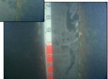
矢板の腐食、開孔
