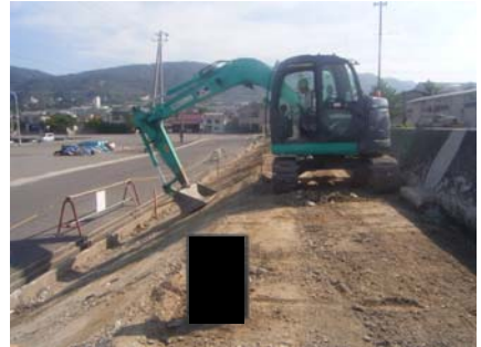
盛土補修状況
