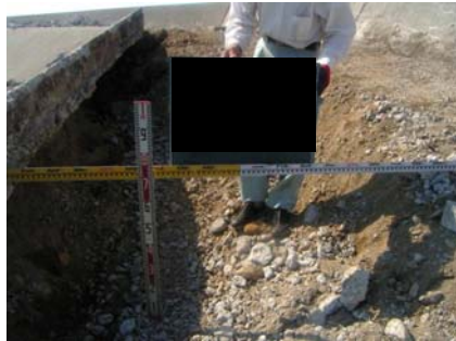
コンクリート取壊し後の空洞化箇所確認
