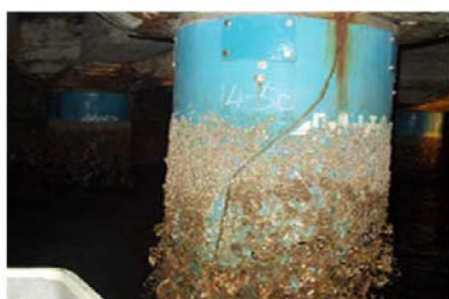
被覆工の外観
