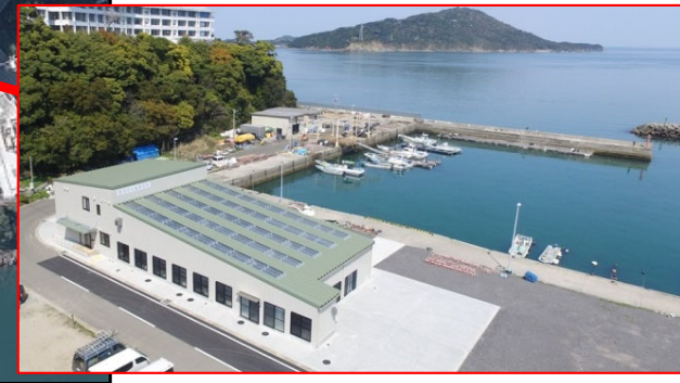
竣工した鳥羽市水産研究所
