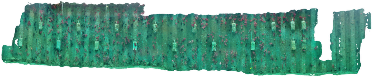
図 4-18 市販ソフトにより結合した画像の例（矢板式係船岸）
