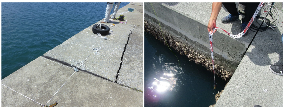
図 4-7 補助ロープ（1m間隔）およびスケール（巻き尺）の設置状況
