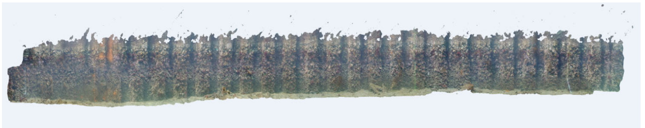
図 4-19 市販ソフトにより結合した画像の例（矢板式護岸）
