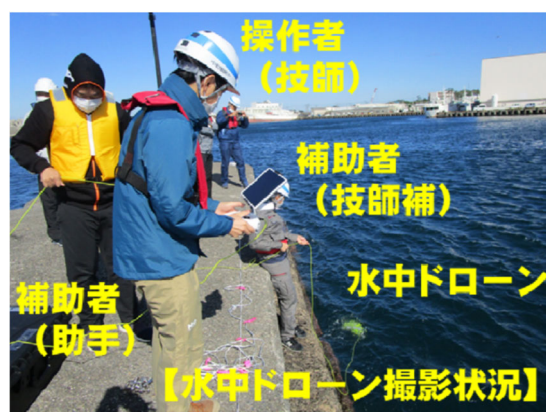
図 4-8 水中ドローンによる撮影状況
