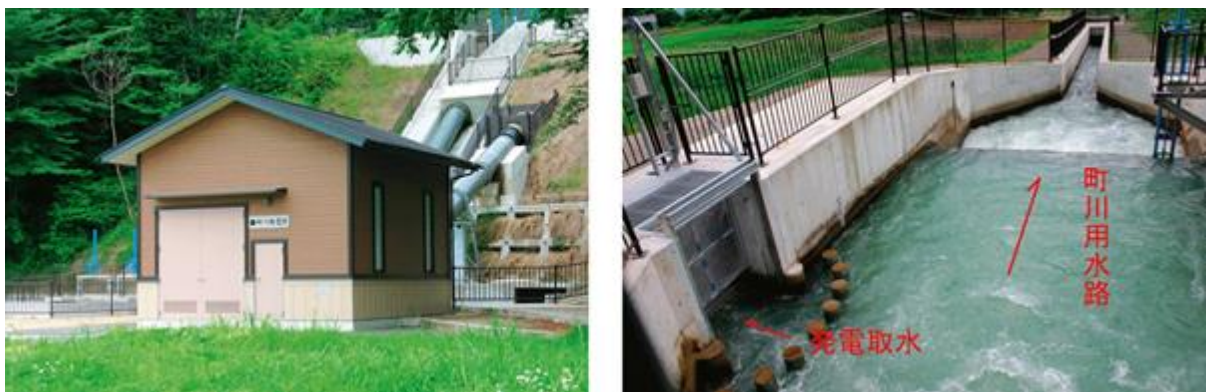
図 1.13 用水路発電設備の一例（町川発電所，最大出力 140kW） 1)
