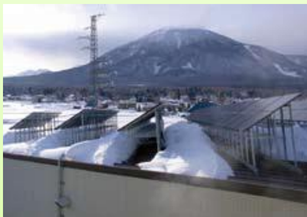
写真 3.8 積雪地域の工場での太陽光パネルの設置事例
