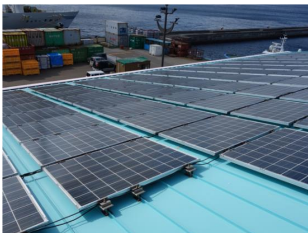
写真 3.9 傾斜屋根の設置例
