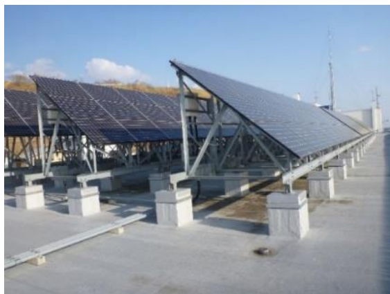
図 2.9 太陽光発電システム設置
