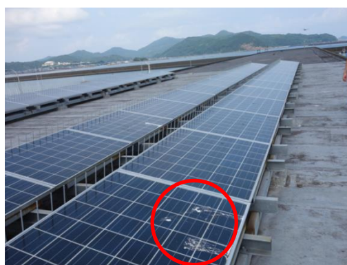
写真 3.4 太陽光パネル（パネル上の糞害）
