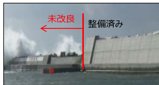
防波堤の高上げによって越波を防ぎ、港内静穏度を確保
