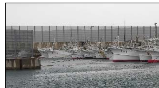
防風施設の設置により港内静穏度を確保
