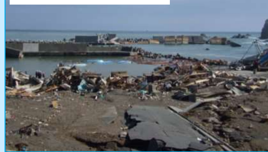
被災当時の漁港状況
