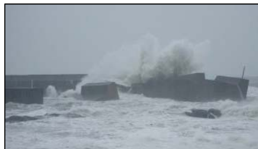
台風により発生した高波が防波堤を越波
