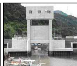
津波・高潮対策としての水門整備
