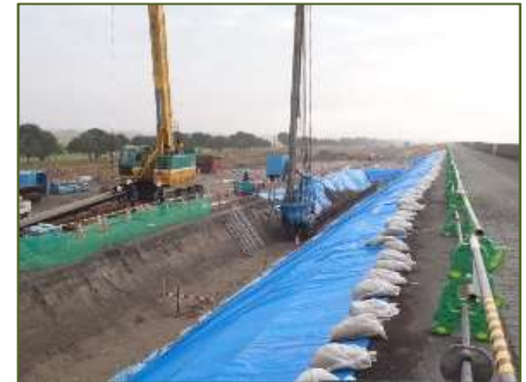
鋼矢板打設による耐震対策
