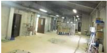
【処理施設内部】
