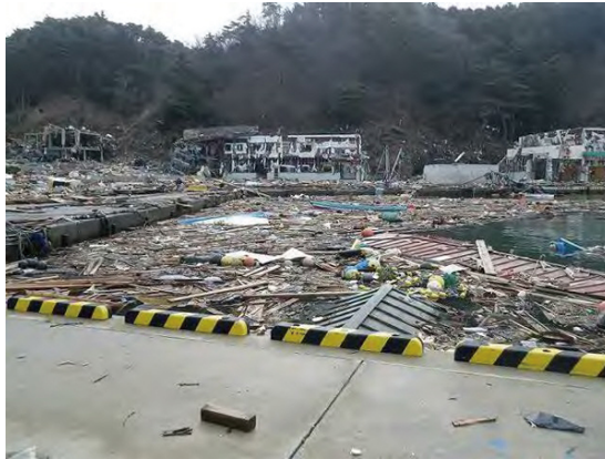
写真 2-1 木材により埋め尽くされた漁港水域施設（宮城県石巻市）
