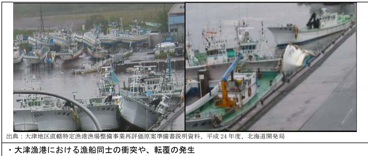
写- 1.14 2011年東北地方太平洋沖地震津波による漁船の衝突被害(北海道大津漁港)
