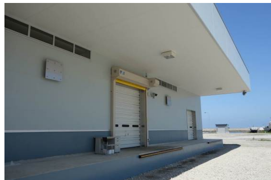
高床式の例 (F 漁港産地市場) 20 cm程度の段差を設けている。
