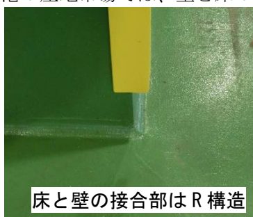
写真-参. 10 H 漁港魚市場 (B 棟) の床と壁の接合部例
