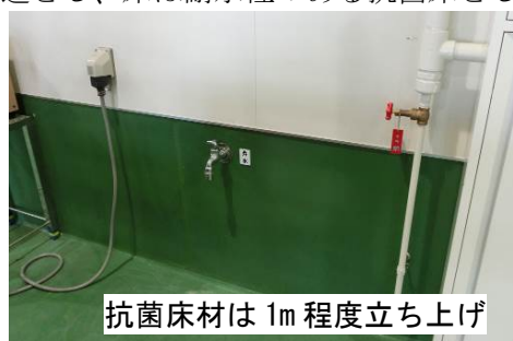
写真-参. 10 H 漁港魚市場 (B 棟) の床と壁の接合部例
