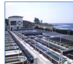
魚類・貝類 種苗生産施設
