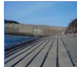
物揚場等の係留施設
