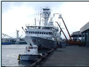
漁船大型化に対応した岸壁
