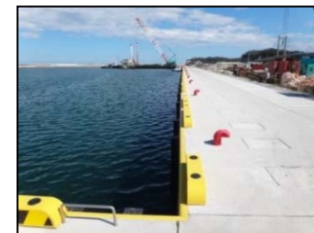
岸壁の耐震強化
