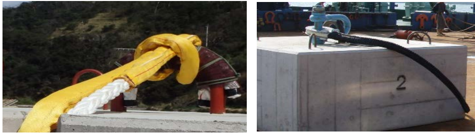
図3-2 シンカー直上の下部主係留索の補強対策 (左：保護カバーによる補強、右：鋼製素材でシンカーと連結する補強)
