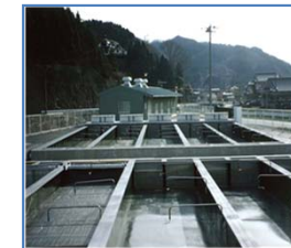
さけ・ます 種苗生産施設
