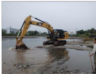
重機による河床整備
