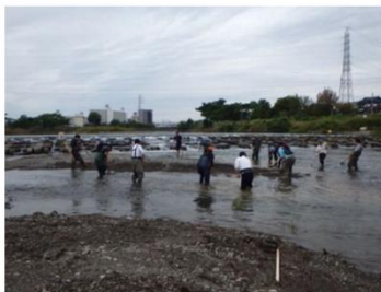
人力による河床整備
