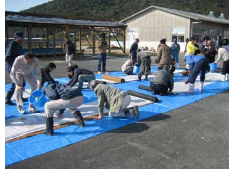
【シートに蒔いて設置する方法】
