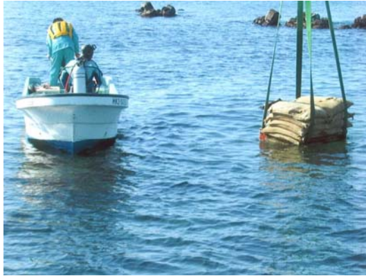
【施肥剤の設置作業】
