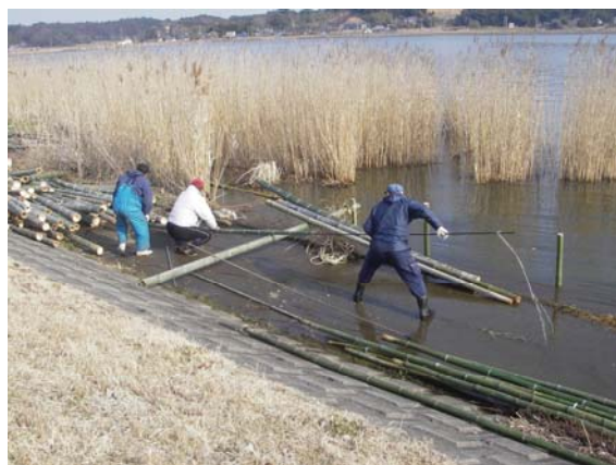
【現場での節抜き作業】
