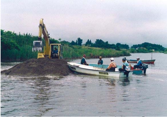
【パワーショベルによる砂の積み込み】
