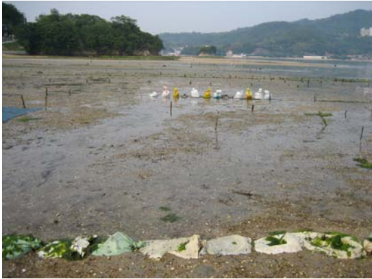
【土嚢袋の設置】
