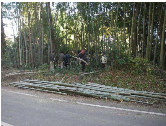
【保護柵用の竹材の切り出し作業】
