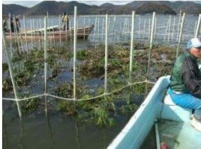
【ヨシ帯の機能を補完する柴の設置】
