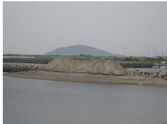
【客土用に仮置している砂】
