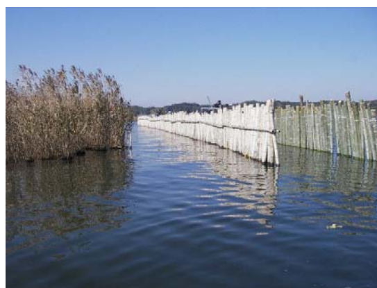
【設置された保護柵】
