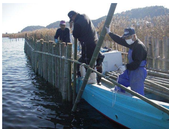
【保護柵の設置作業】
