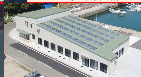
竣工した鳥羽市水産研究所
