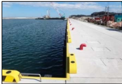
岸壁を耐震強化することで、緊急物資の荷揚げが可能
