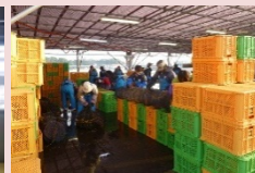
漁港施設用地への屋根整備
