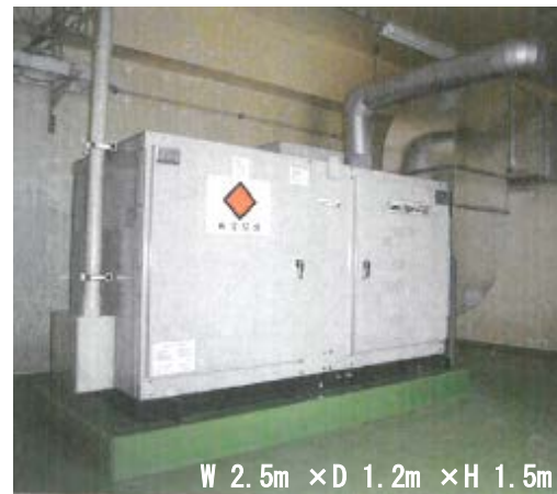
非常用電源の設置
