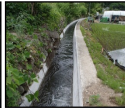
老朽化した用水路の整備・更新
