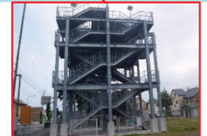
避難路・避難地整備対象地域の拡大
