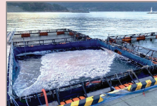
海水馴致施設
