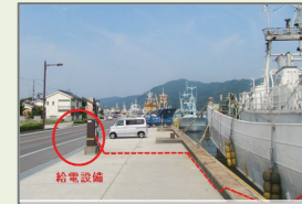
電力供給設備の整備
