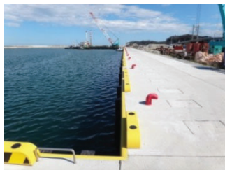
岸壁を耐震化することで、緊急物資の荷揚げが可能
