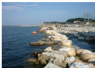
地震により岸壁が倒壊
