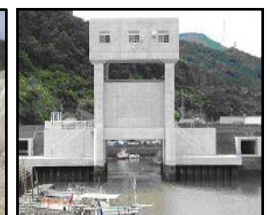
津波・高潮対策としての水門整備
