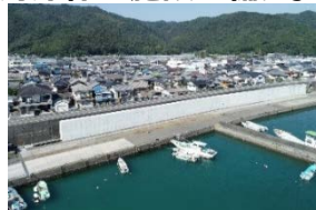
防潮堤整備による津波対策
