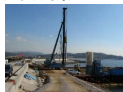
堤防の地盤改良による耐震対策
