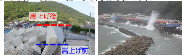
護岸の高上げ改良による高潮・高波対策
