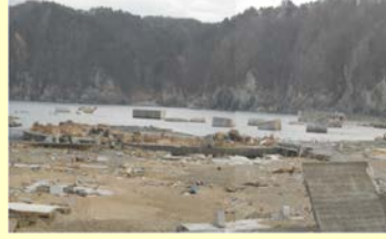
津波による防波堤及び海岸堤防の被災
