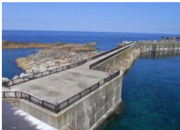
防波堤に転落防止柵を設置
