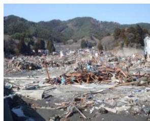
集落の被災状況
