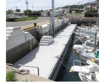
浮桟橋の整備
