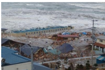
津波の来襲状況
