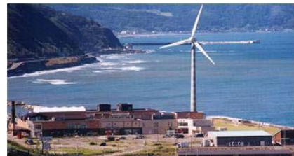
漁港内に設置された風力発電施設 (名立漁港(新潟県))
