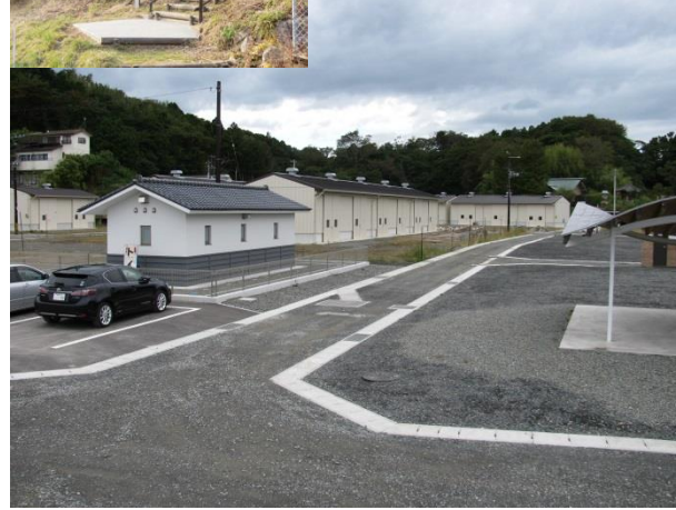
低地部の住宅跡地は 水産用地として整備
