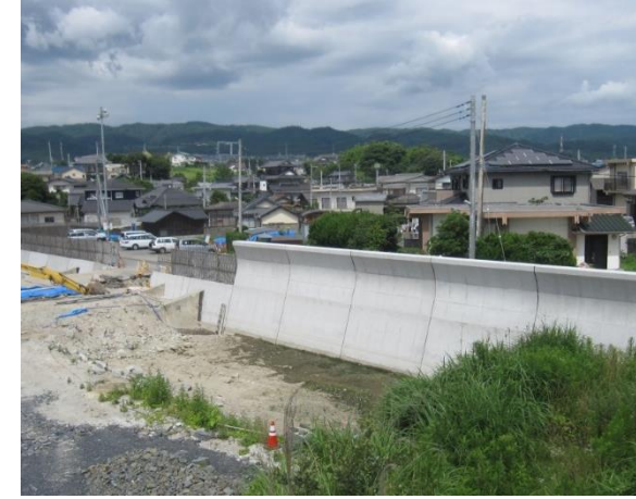
集落を守る防潮堤の整備
