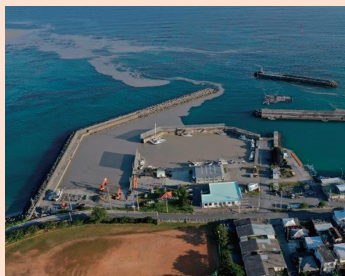
沖縄県 へとな 辺土名漁港の（左）大量の軽石の漂流・漂着による埋そく状況、 （中）軽石除去作業前の港内、（右）軽石除去作業後の港内
